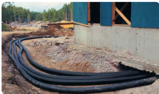
Ввод теплоизолированных труб в здание.
