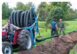
Поставка на место выполнения работ в соответствии с заказом; монтаж непосредственно из бухты.
