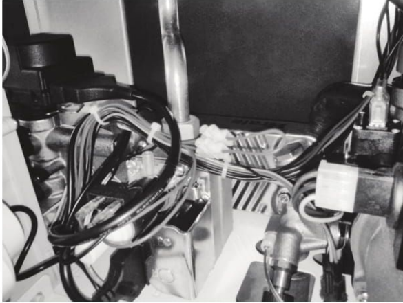
рис. 7 – Доступ к клеммной панели
