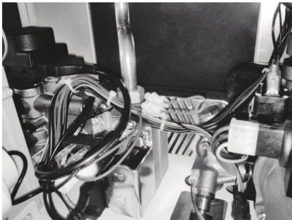
рис. 7 – Доступ к клеммной панели
